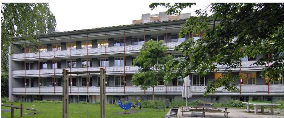
نمای طولی ساختمان در سمت زمین بازی کودکان.
