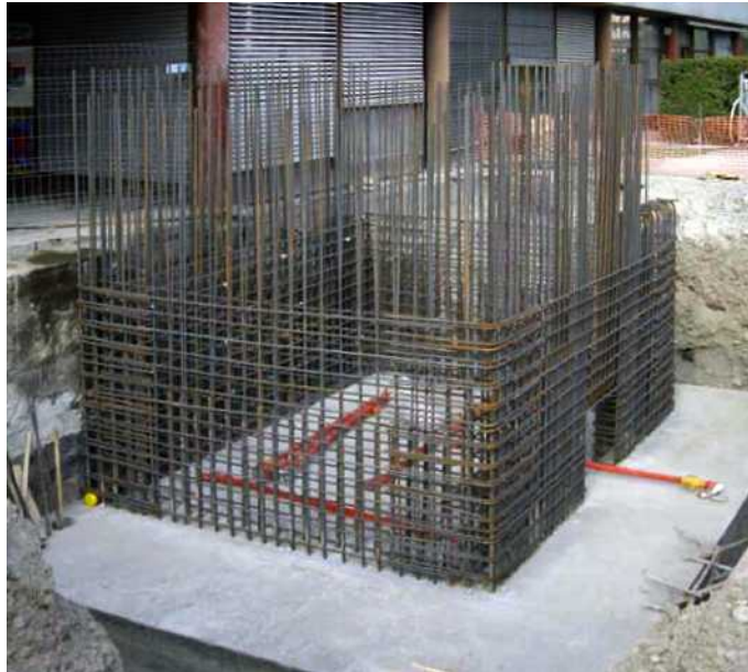
آرماتوربندی در طبقه زیرزمین و شالوده برج پلکان جدید.
