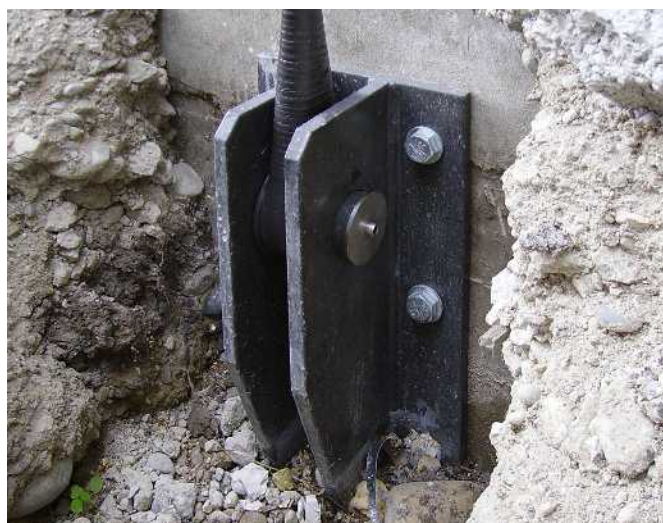
مهار تحتانی میله‌های کششی الیاف کربن در کنار دیوار زیرزمین.
