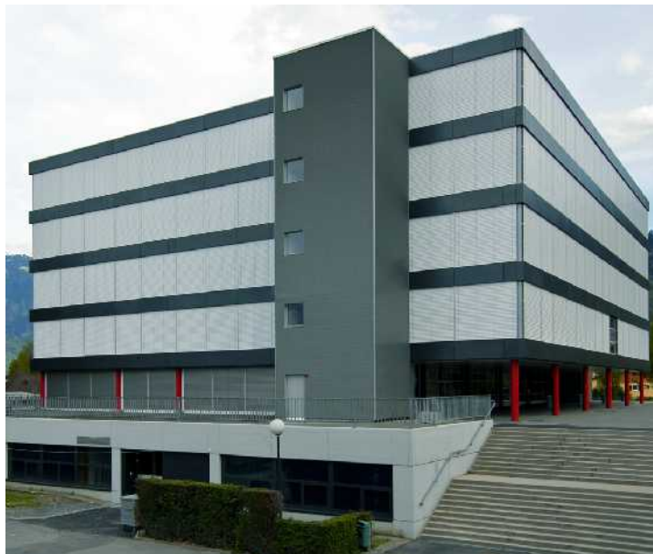
نمای برج پلکان جدید در وجه شمالی ساختمان.
