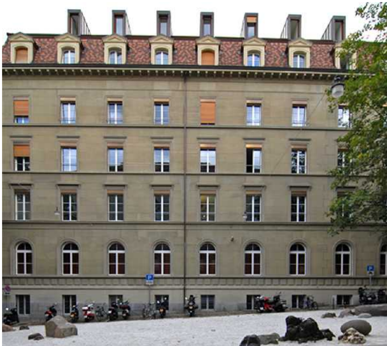
نمای شرقی ساختمان
