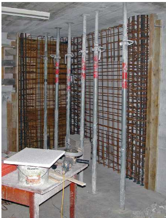
آرماژورگذاری یکی از دیوارهای جدید بتن مسلح در تراز زیرزمین.
