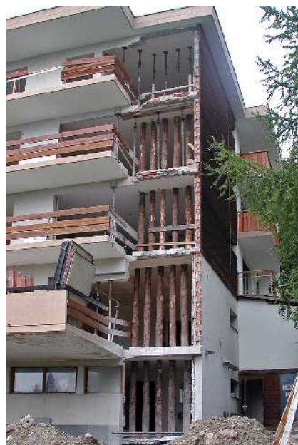
عملیات اجرایی در کنج جنوب شرقی ساختمان.
