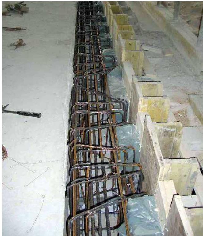
مهار آرماتورهای کف جدید در دیوارهای بنایی.
