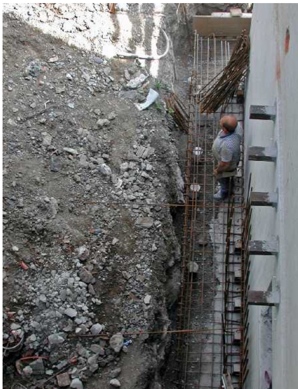
پی دیوارهای بتن مسلح جدید.
