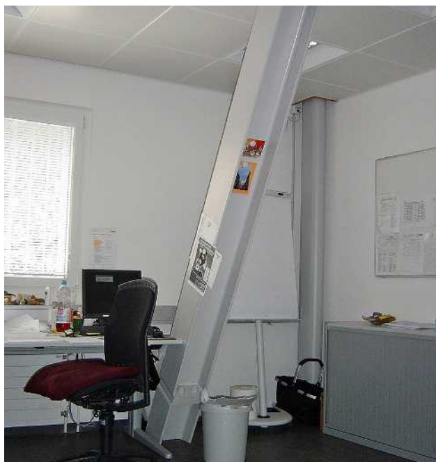
عضوی از خرپای فولادی V شکل جدید در اتاق اداری طبقه همکف.
