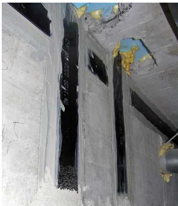
مقاوم‌سازی شفت آسانسور با استفاده از نوارهای الیاف کربن (FRP).
