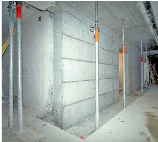
دیوار همبسته بتن مسلح جدید در زیرزمین ساختمان.
