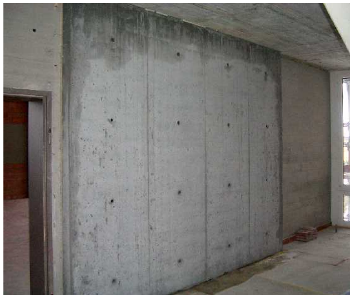
تقویت یکی از دیوارهای موجود با دیواری به ضخامت ۱۵ سانتی‌متر.
