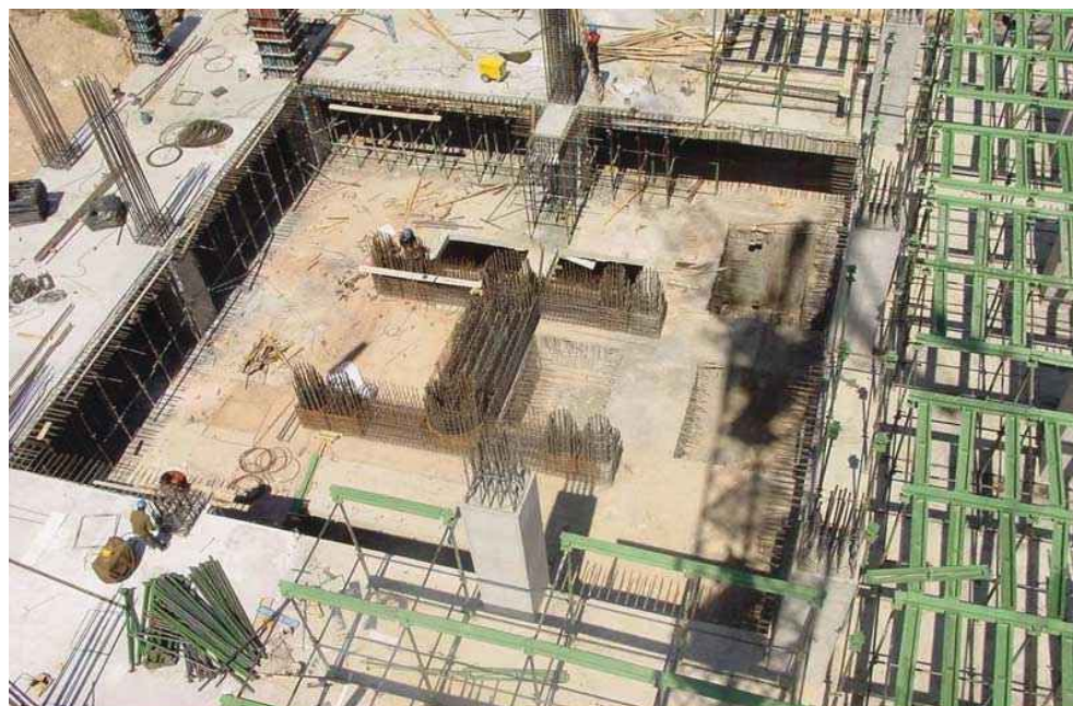
شکل ۳۲.۲ اجرای هسته مرکزی در مرکز تجارت جهانی تبریز
