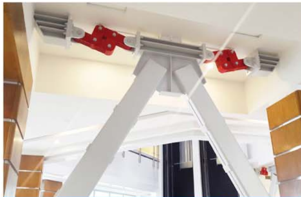
ساختمان مرکزی بانک گردشگری
