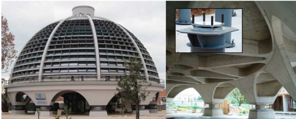
تجهیز به جداسازهای اصطکاکی پاندولی
