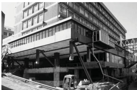
شکل ۱۳.۱ زیر قسمتی از بالکن، تکیه‌گاه نصب شده است تا سیستم جداساز پایه نصب شود (کتابخانه، ولینگتون)
