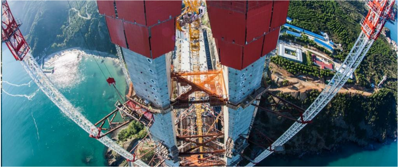
داریست روی برج اصلی در عملیات ساخت و ساز
