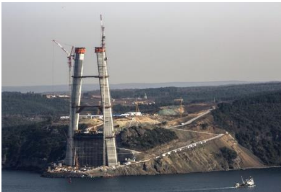
عملیات ساخت برج های تکیه گاهی اصلی
