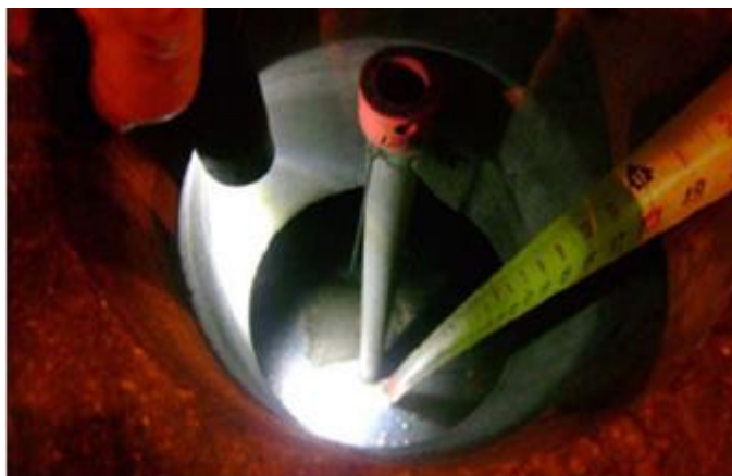
شکل دو. حفره با چهل اینچ عمق در زیر روسازی بتنی
