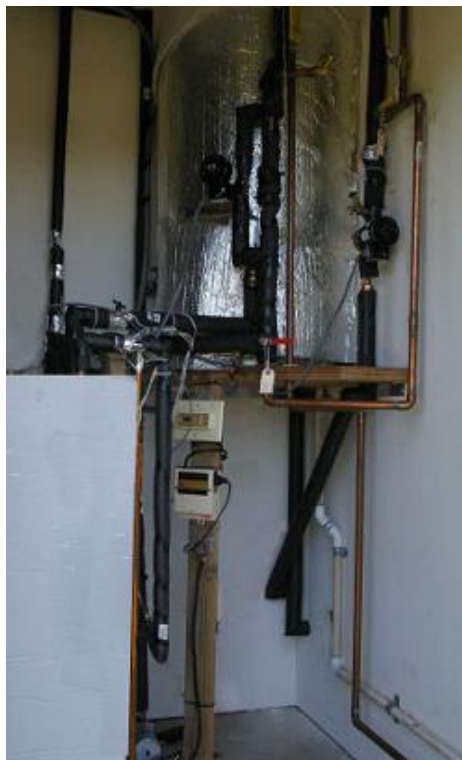
شکل ۵. مخزن ذخیره (سمت چپ پایین)، مخزن ۴۰ گالنی تحت فشار (سمت راست بالا)
