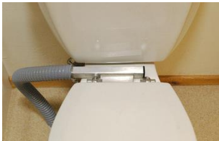
شکل ۱۶. تهویه هوا در سرویس بهداشتی معمولی
