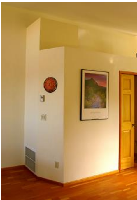
شکل ۱۳. گرمایش فن کویل. هوا از سمت راست بالا داخل و از سمت چپ پایین خارج می شود.
