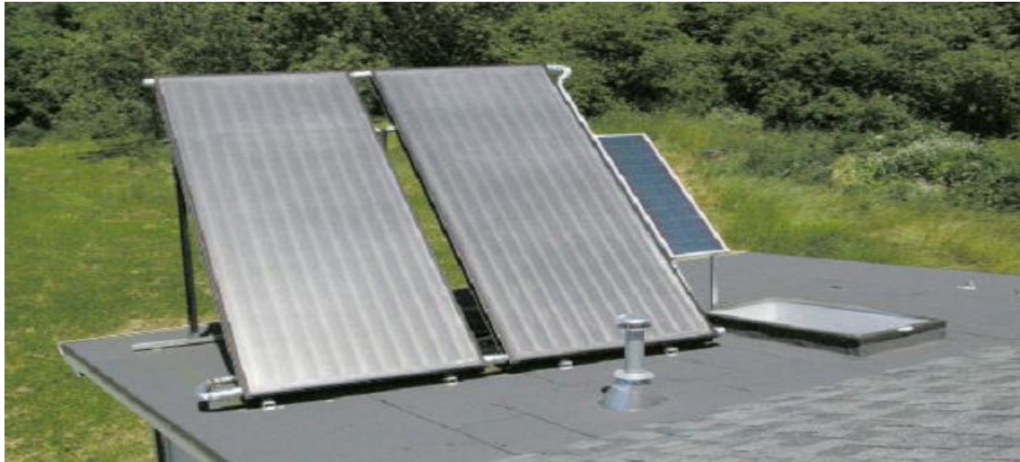
شکل ۴. پنل های حرارتی خورشیدی و سیستم PV
