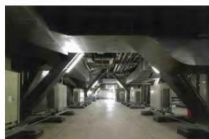
شکل ۵. طبقات دارای کمر بند خرابایی
