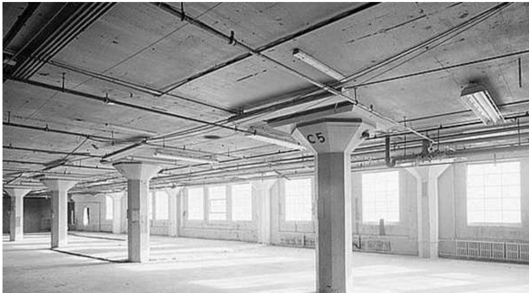
شکل ۲: سیستم کف دال مسطح
