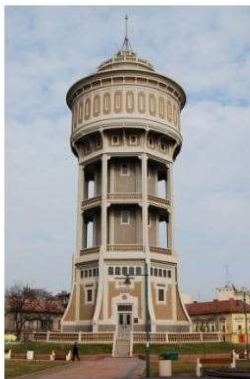
شکل ۲: سازه‌ی بتن مسلح برج آبی قدیمی که همچنان پابرجاست
