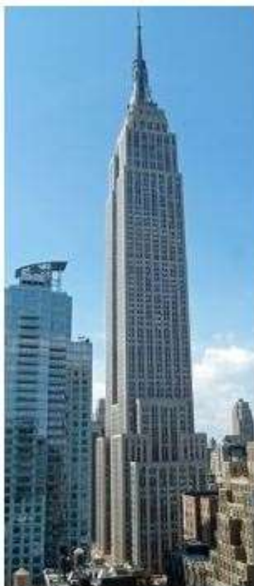
شکل ۲: ساختمان ایالت امپراتوری در نیویورک
