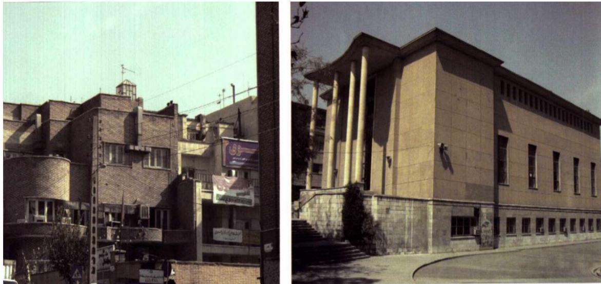
تصویر ۱ (سمت چپ): استفاده گسترده از آجر در نماسازی ساختمان‌های سال‌های ۱۳۰۰-۱۳۳۰ (مناطق مرکزی شهر تهران)
