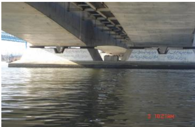
جانمایی نادرست تکیه گاه نئوپرن در پایه ها
