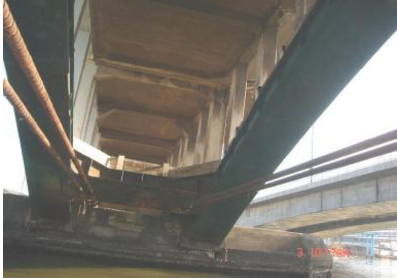
تصویر زیر اتصال تیر ورق به کلاهک شمع را نشان می دهد.
