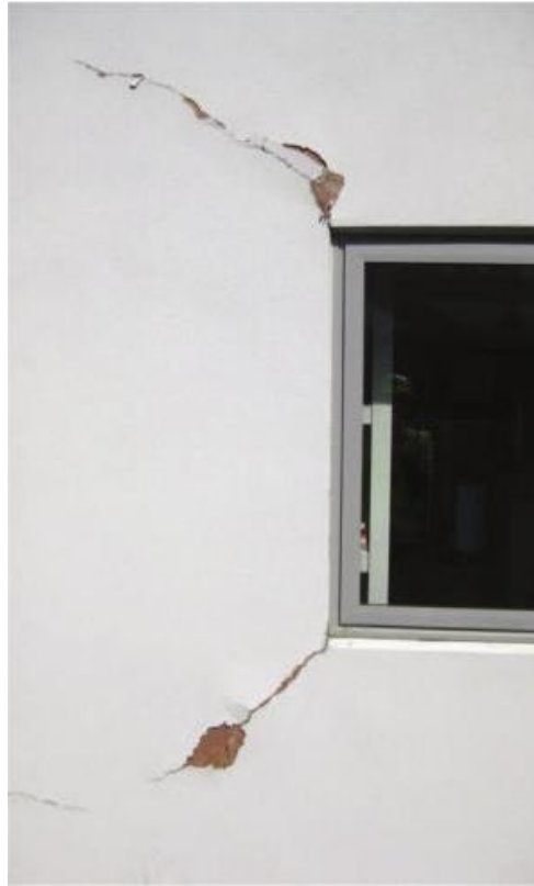
وقوع خرابی در یک روکش یکپارچه‌ی سبک وزن در زلزله‌های کریست چرچ (BRANZ)
