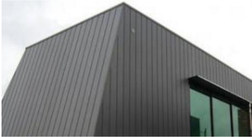
یک نمونه روکش سبک وزن فلزی بر روی یک ساختمان تجاری کم ارتفاع
