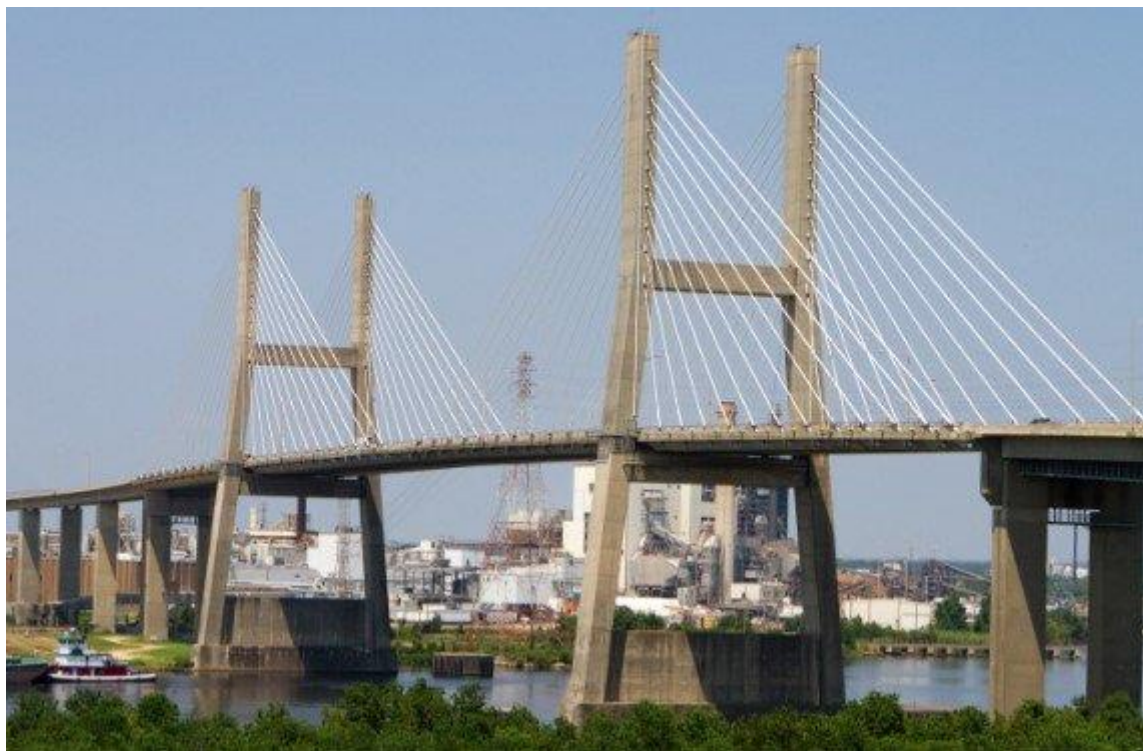
شکل ۱۰. اتصال ستون‌ها با عضو فشاری افقی باعث افزایش پایداری آن می‌شود
