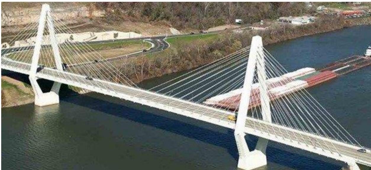
شکل ۶. برج بتنی پل
