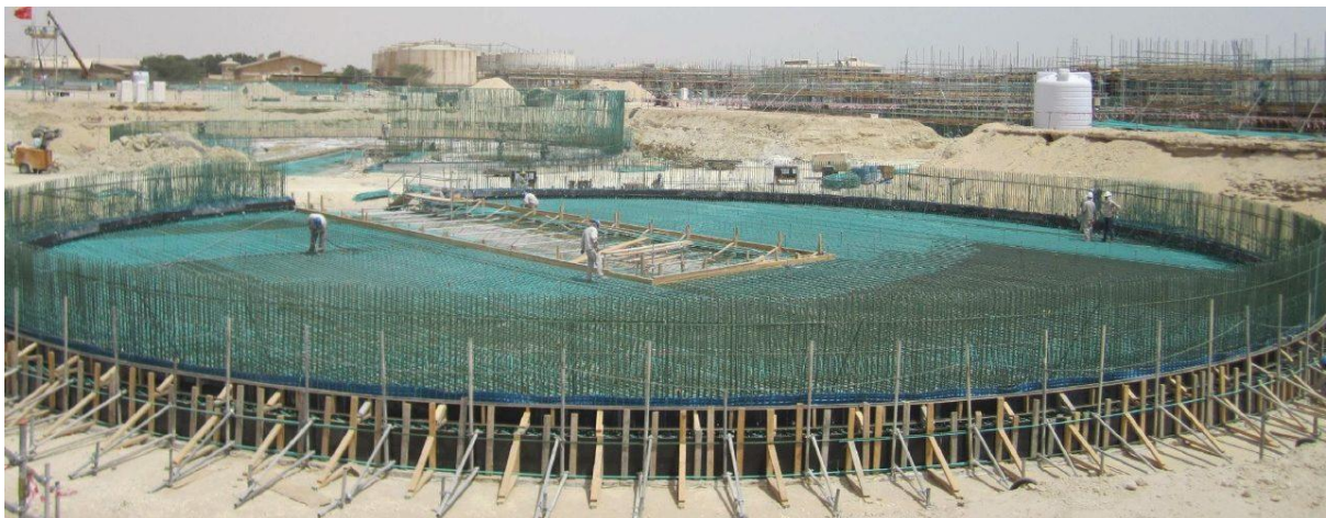
ساخت مخزن آب
