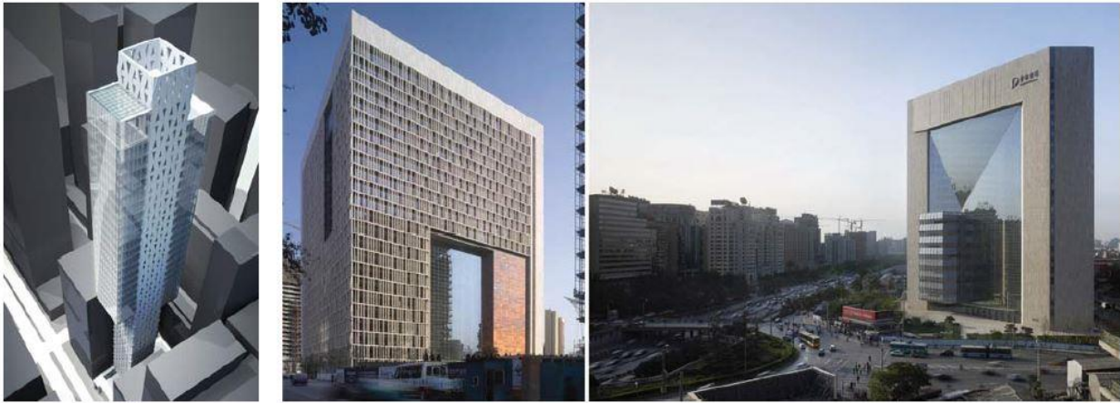
شکل ۲. چشم‌اندازهای خارجی، دفتر مرکزی شرکت Poly، پکن شکل ۱. طرح هوایی خانه Takshing
