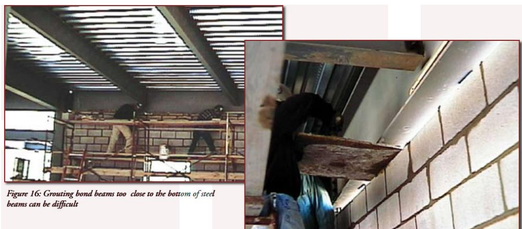
شکل ۱۶: دوغاب ریزی تیرهای مقیدی که خیلی نزدیک به پایین تیر اصلی هستند می‌تواند دشوار باشد.
