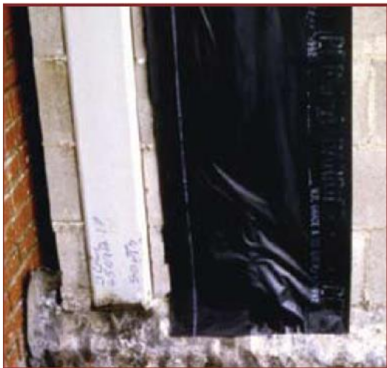
شکل ۳- ب: ستون و فضاها به وسیله غشا درز گیر محافظت شده‌اند.
