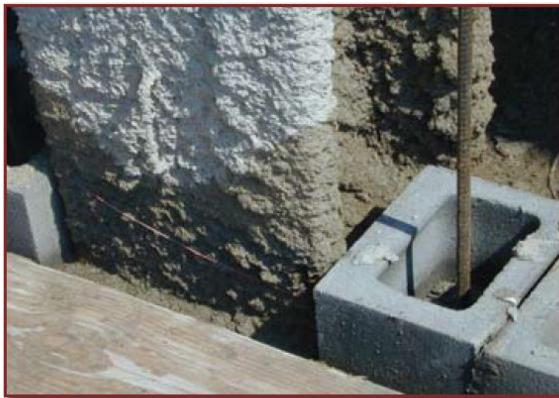
شکل ۹: دیوارهای دارای عایق حرارتی یا فضای خالی.
