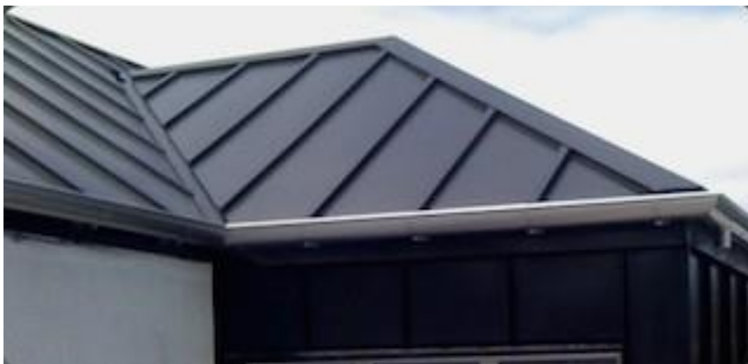
ورق‌های فولادی نمونه‌ای از پوشش‌های سبک سقف هستند.
