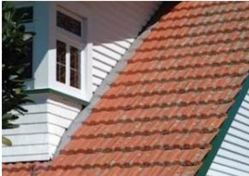
کاشی‌های رسی نمونه‌ای از سقف‌های سنگین هستند که نیازمند جزئیات نصب دقیقی می‌باشند
