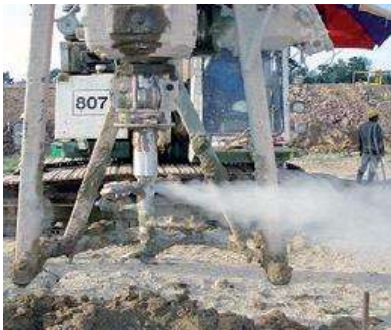
تزریق ملات خشک از ابزار اختلاط
