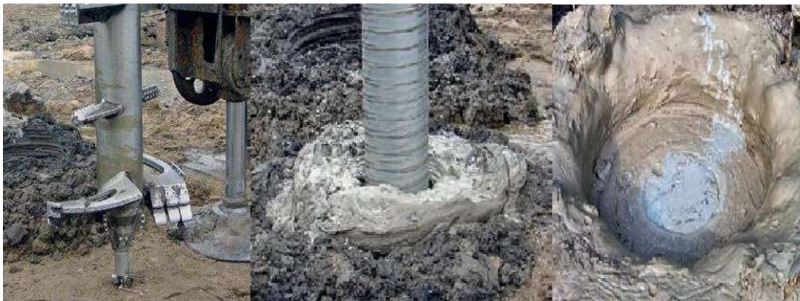
نصب ستون اختلاط عمیق خاک
