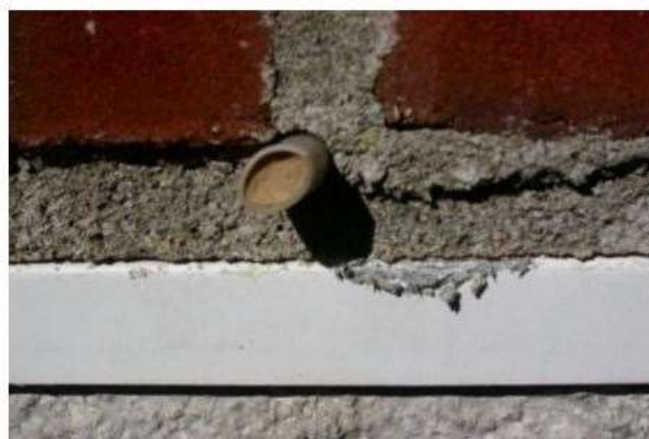
شکل ۶. حفره‌ی پر شده خروج آب در دیوار بنایی که باید تمیز شود.
