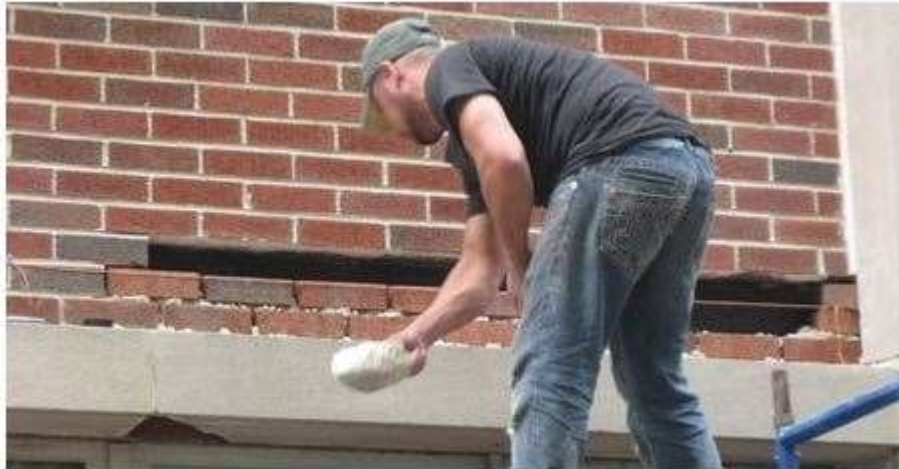
شکل ۷: حذف و جایگذاری دیوار بنایی آسیب‌دیده
