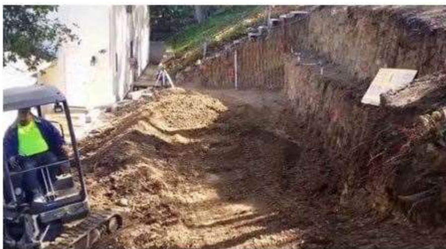
شکل ۳. خاک‌برداری و شیب بندی برای ساخت دیوار حائل
