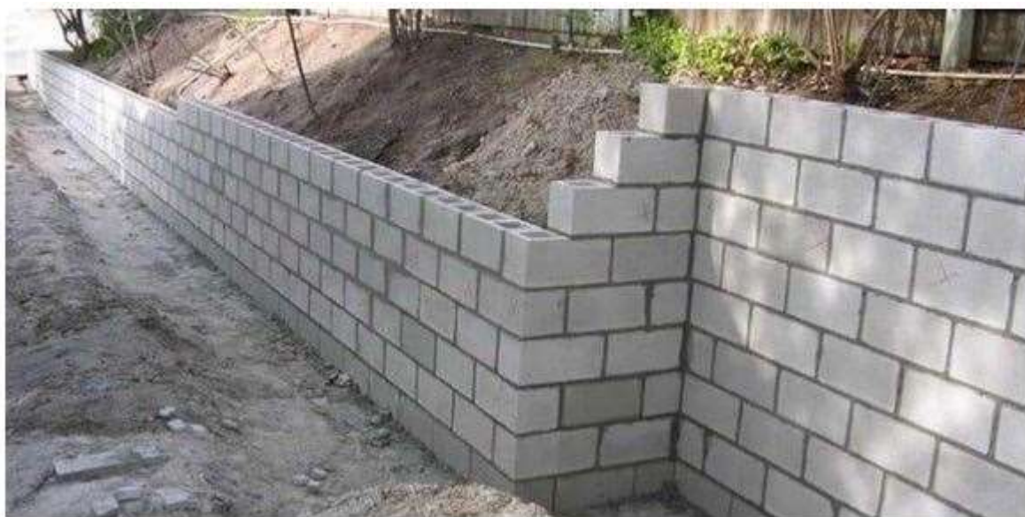
شکل ۱: دیوار حائل بلوک بتنی (SEXTON, ۲۰۱۷)
