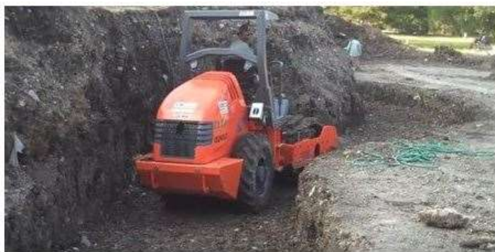
شکل ۴. تراکم خاک فونداسیون
