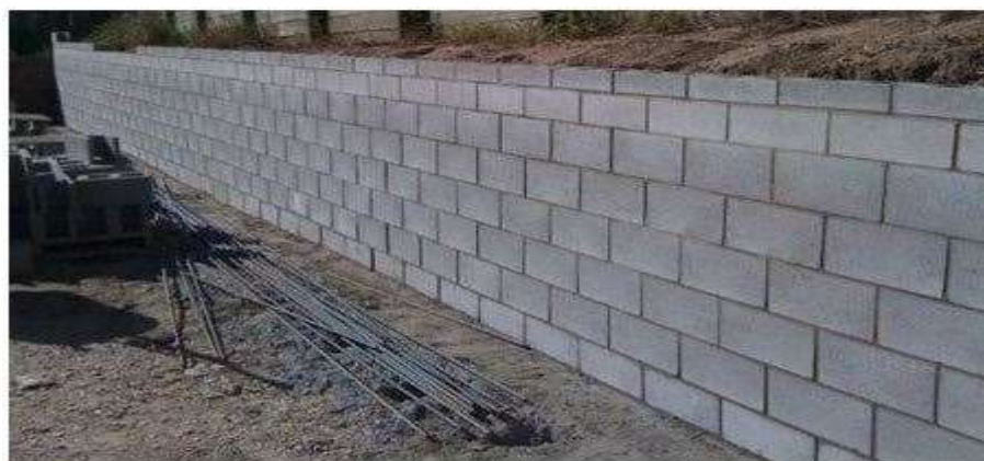
شکل ۲: دیوار حائل بلوک بتنی (GADANG, ۲۰۱۷)
